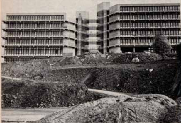
Die Bauten für die Gesamthochschule auf dem Gelände Schreiners Wiese am Griffenberg gehen zügig weiter. Unser Bild zeigt den Stand der Bauarbeiten für das Verfügungs-zentrum, das bald in Betrieb genommen werden soll.
